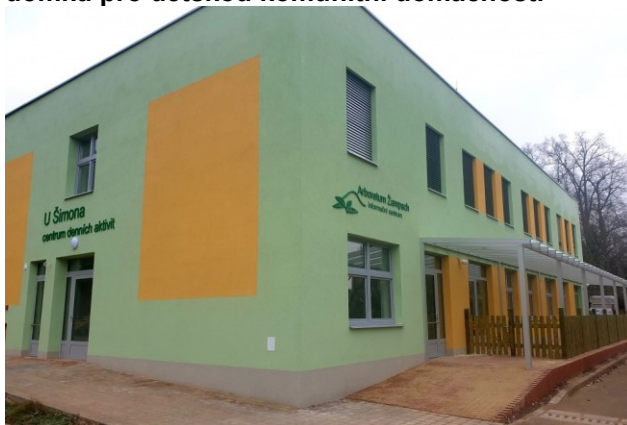
CDA v budově U Šimona po její rekonstrukci v roce 2020
