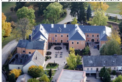
Záměcká budova po rekonstrukci, 2008
