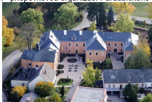
Záměcká budova po rekonstrukci, 2008
